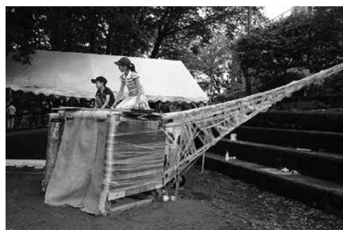
(写真14) 2012年 「空にむかってつくる」WS (北杜市)
